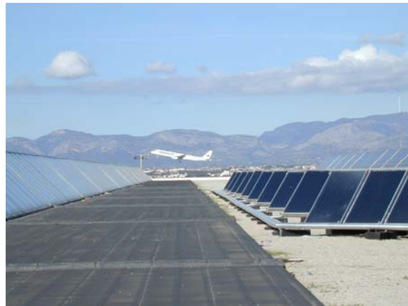
Instalación ACS Palma de Mallorca
