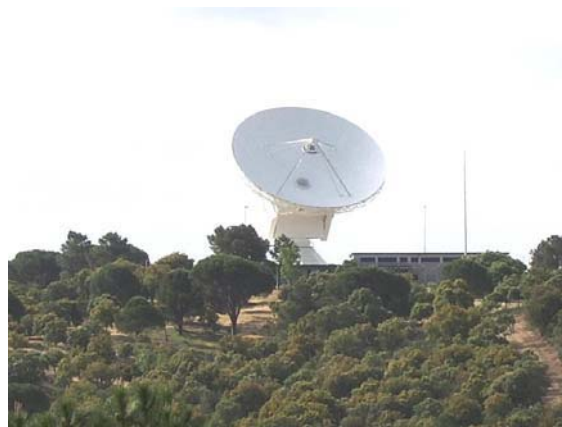
Estación de Espacio Profundo de la ESA en Cebreros (Ávila)
